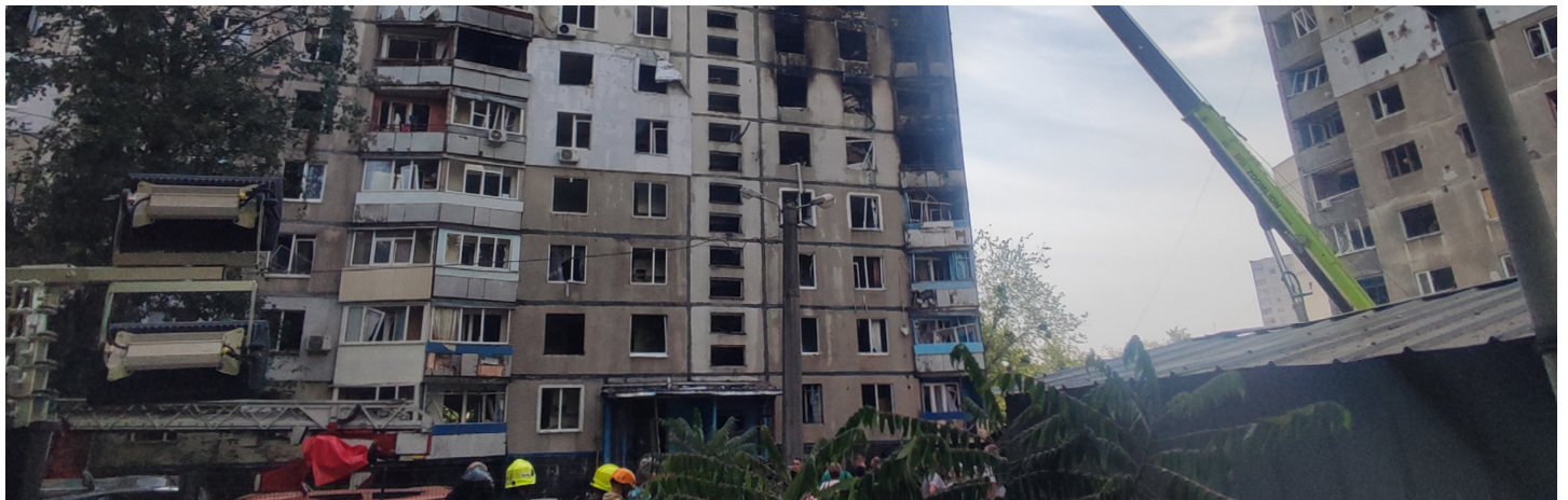
Жилой дом в Харькове, поврежденный в результате обстрела 30 августа 2024 года.
